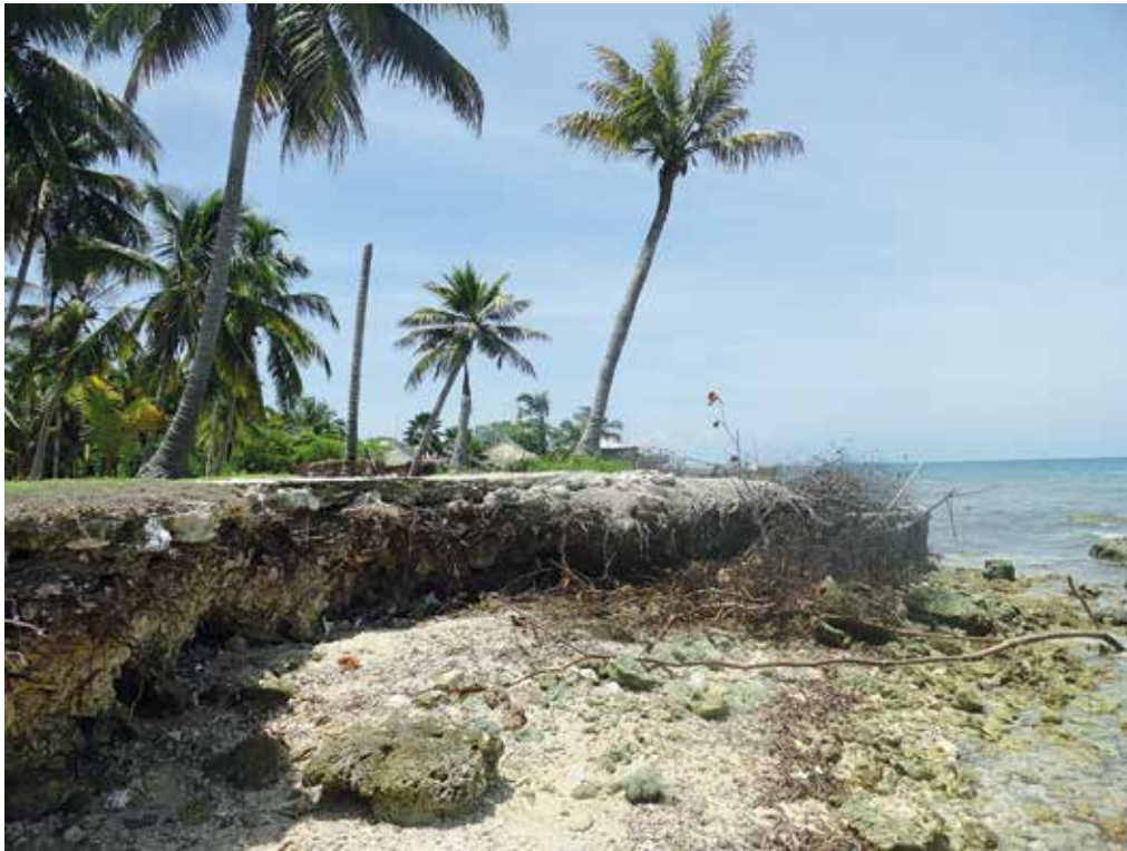
Foto 9. Erosión costera en Isla Fuerte.
